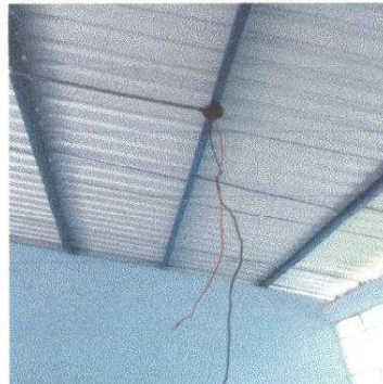
Reparacion de Sistema Electrico
