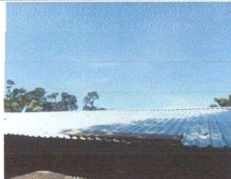
Suministro e instalacion de Cubierta de Lamina
