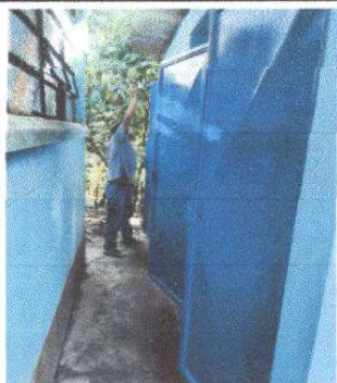
Mantenimiento de Puertas de Metal
