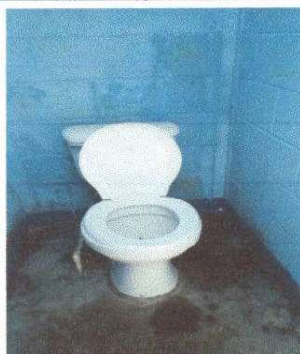
Suministro e instalacion de Sanitarios
